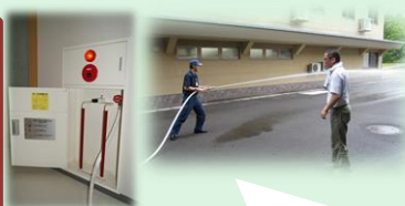
◎屋内消火栓、取り扱いの確認と放水訓練を行いました。
